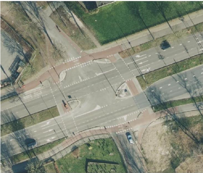
Figuur 4: Door wegbeheerder aangedragen GOW-GOW voorrangskruispunt in Zwolle. Dit voorrangskruispunt ligt op een voorrangsweg waar de overige kruispunten met een VRI geregeld zijn.
