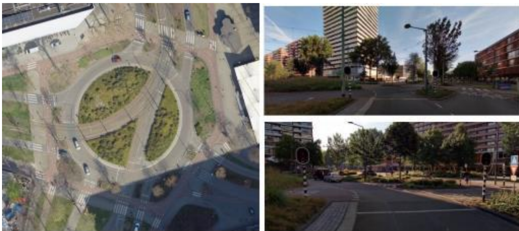
Figuur 3 Delflandplein in Delft: combinatie van rotonde en VRI
