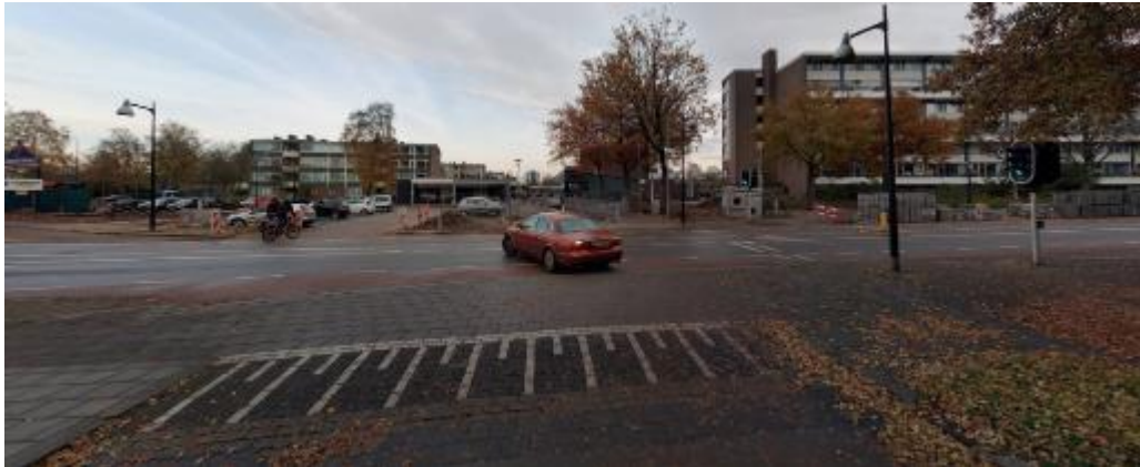
Figuur 4 Voorrangskruispunt met uitritconstructie voor de zijweg en voetgangerslichten voor het oversteken van de hoofdweg
