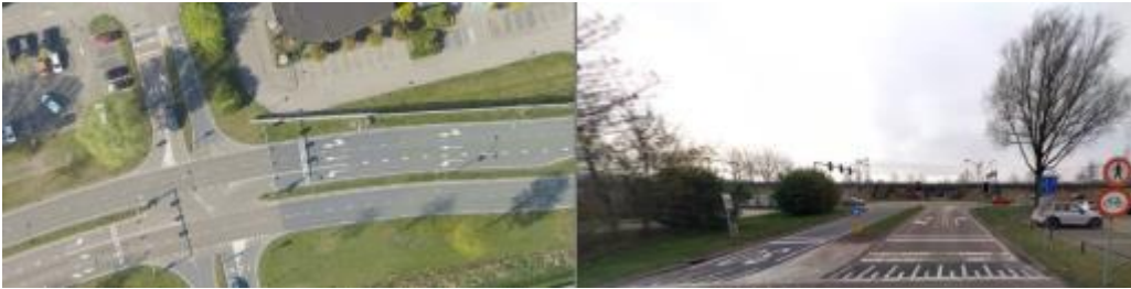
Figuur 9 Kruispunt in Almere met geslotenverklaring voor langzaam verkeer
