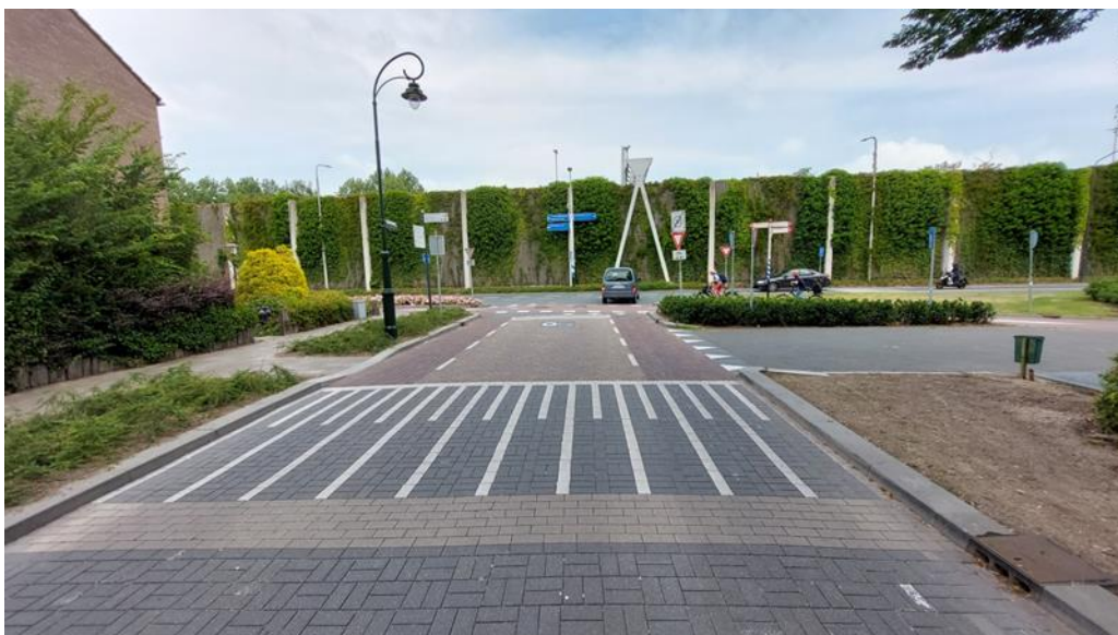
Figuur 23 voorbeeld van een voorrangskruispunt tussen GOW-ETW dat relatief goed zal scoren, maar vanwege beperkt zicht toch een hoog ongevallebeeld kent.
