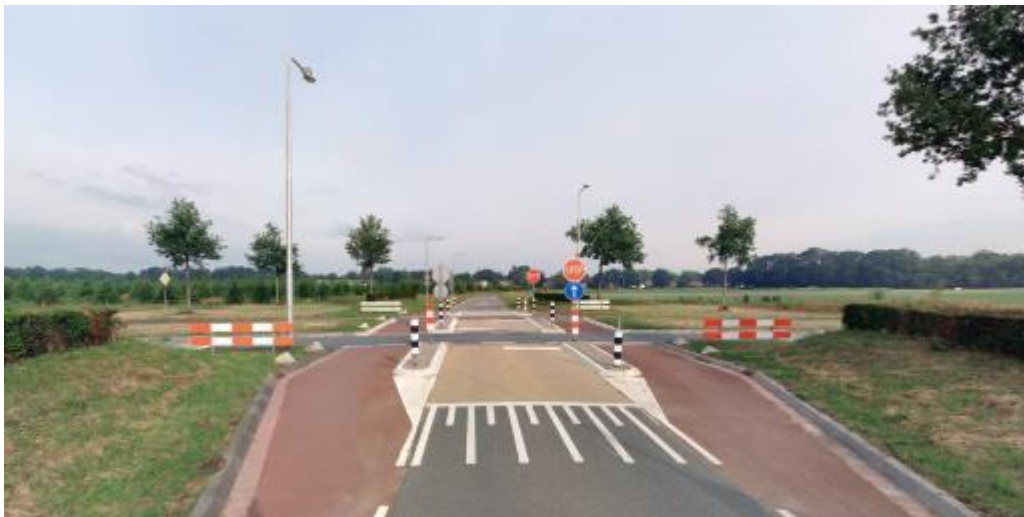
Figuur 13 Voorbeeld kruising met de kijkrichting naar een erftoegangsweg vanaf waar niet afgeslagen mag worden
